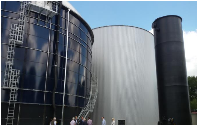
Im c-Port sollen 40 solcher Türme entstehen; Foto: Dr. Kannen.
